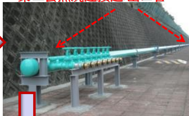
第二套熱沉連接進/出口管
