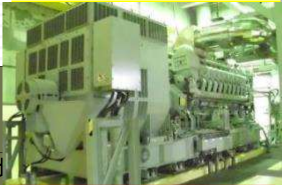
5號柴油機為氣冷式柴油機,可同時支援兩部機組.
