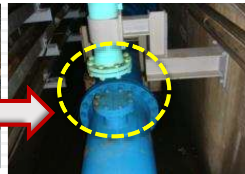
安裝短管連結ECW管路
