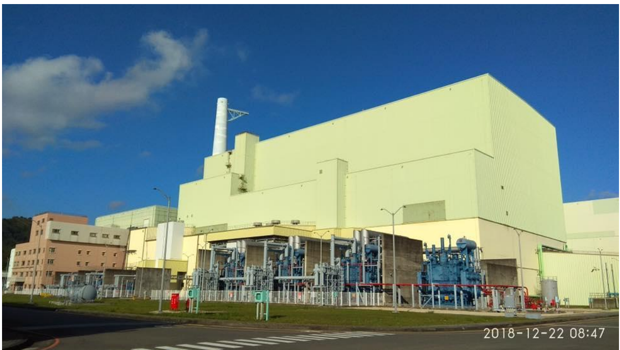
核四廠一號機
