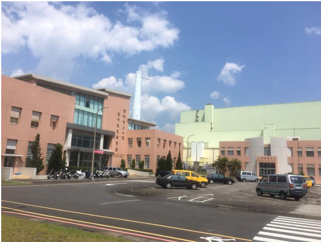
從核四廠的訓練中心及辦公大樓遠眺核四廠一號機
